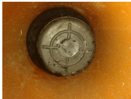
Sperrblase beim Einführen und Sperrblase aufgepumpt mit 1 – 1,5 bar
