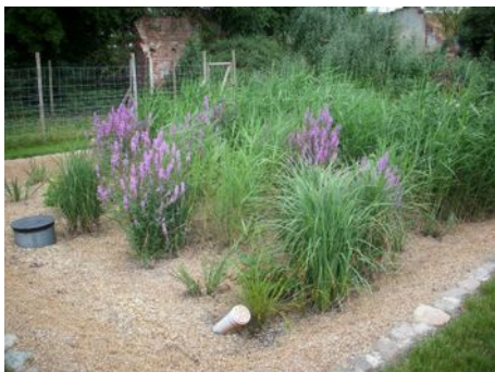
Diese Pflanzenkläranlage ist 3 Jahre alt (Baujahr 2012, Typ 2 für 4 Einwohner) Das Bild stammt aus dem Spätsommer 2011
