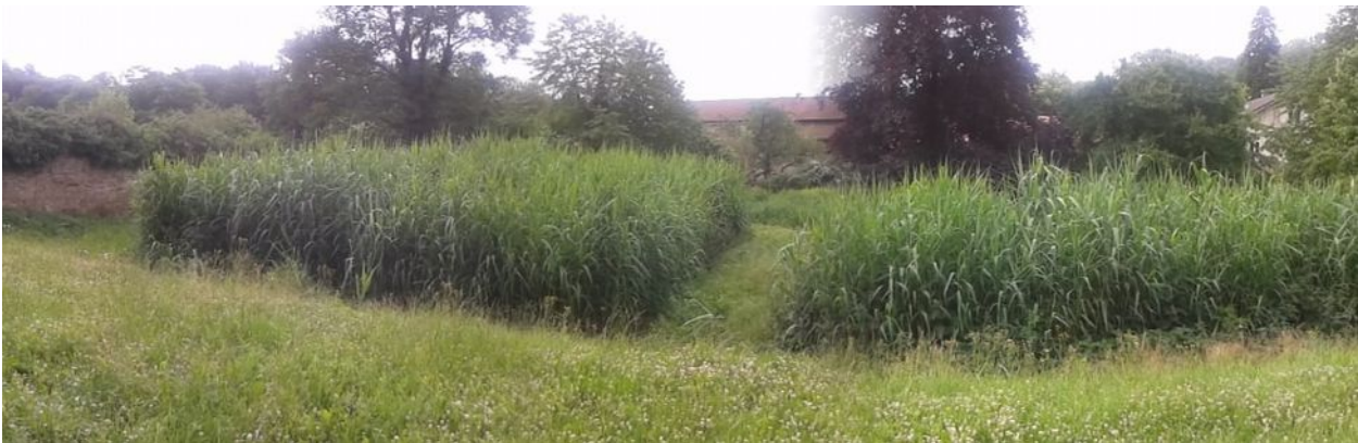
RITTERGUT ALTENRODE, BEI GIELDE. BAUJAHR 2001, FOTO AUS 2013. DIESE ANLAGE LIEFERT SEIT JAHREN BESTE ABLAUFWERTE!
