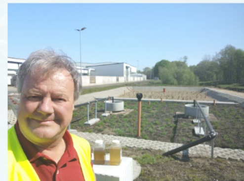
Pflanzenkläranlage für Niederschlagswasser an einem Kompostwerk bei Hunteburg / Kreis Osnabrück
