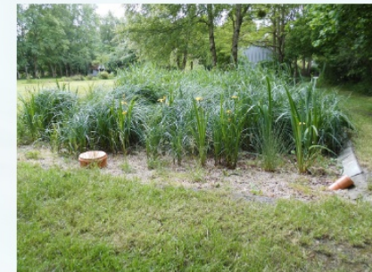
Horizontalfilter im Kreis Aurich
