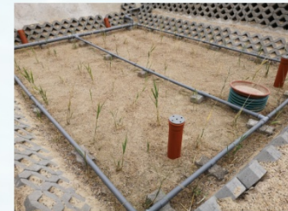
neuer Vertikalfilter im Kreis Nordsachsen
